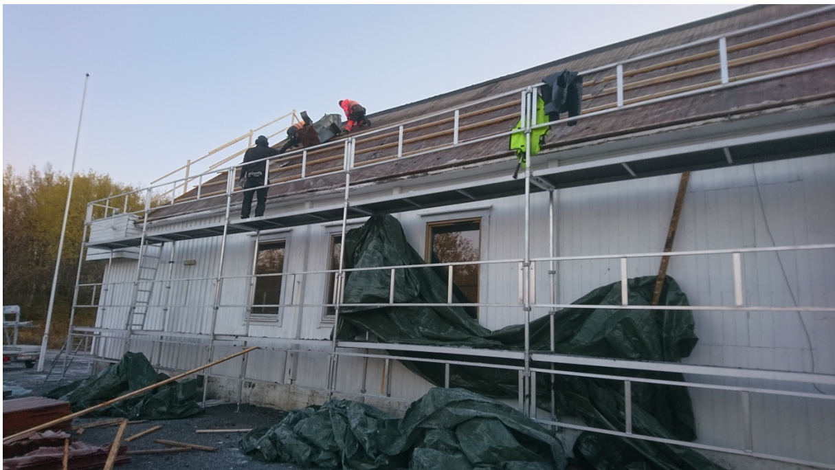
Figur 2. Riving av luftelur på vestsiden av taket. Bernt Magne Mikalsen, Espen Bakklund og Mads Karlsen. Alle fra Ertenvåg Bygg og Maskin AS.
