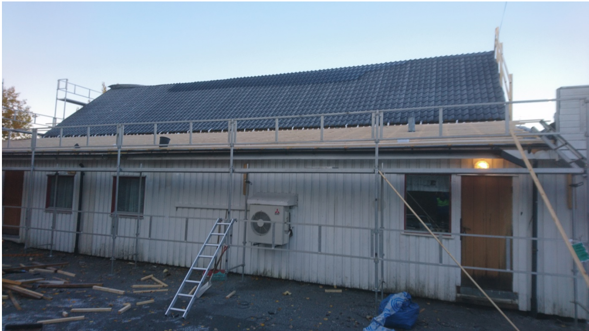
Figur 1. Nytt tak på Østsiden 15.10.2019. Taket over restauranten monteres senere.
